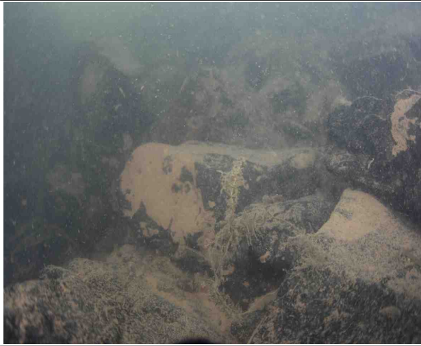
P4하행 교각 보호사석, 상태 양호
