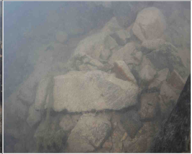
P4하행 교각 보호사석, 상태 양호
