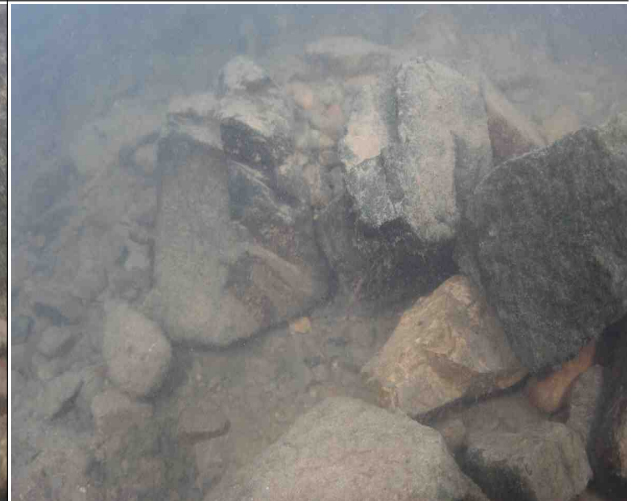
P4하행 교각 보호사석, 상태 양호
