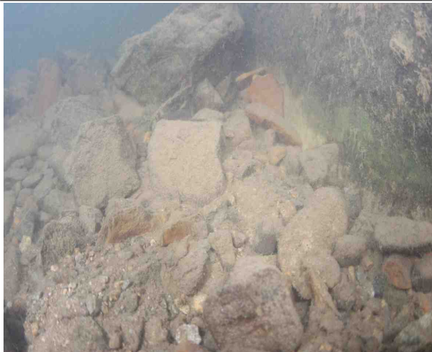
P4하행 교각 보호사석, 상태 양호
