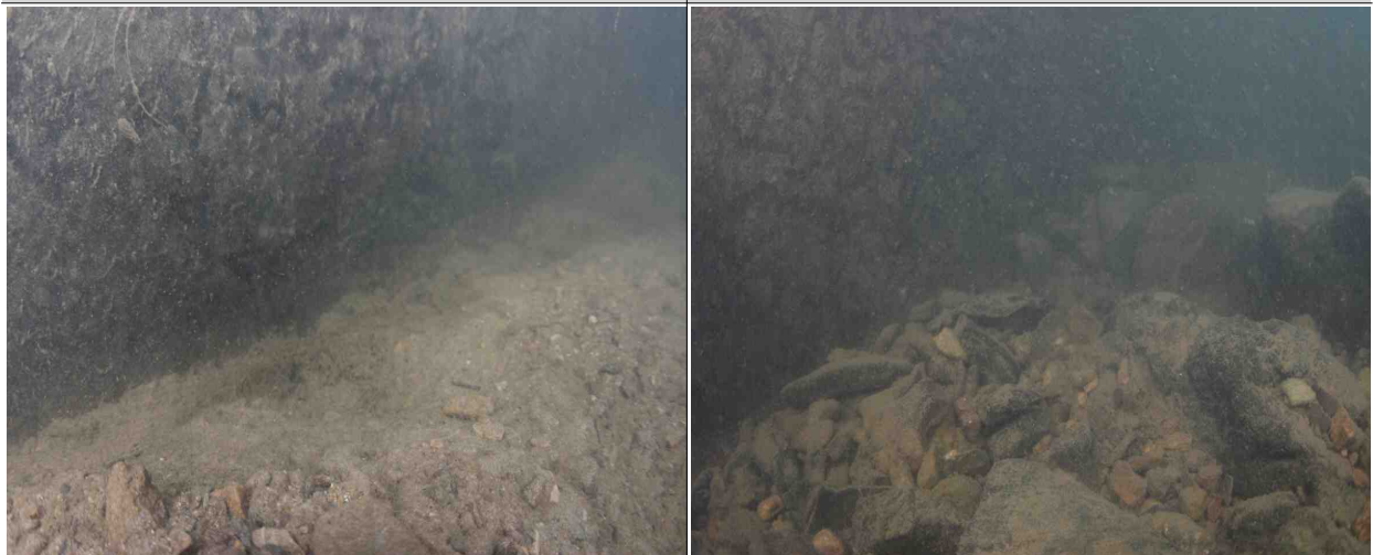
P4하행 교각 기초저면, 상태 양호
