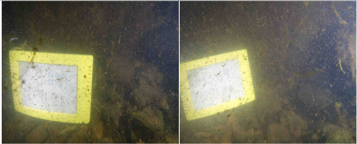
P3하행 교각 기초저면, 상태 양호
