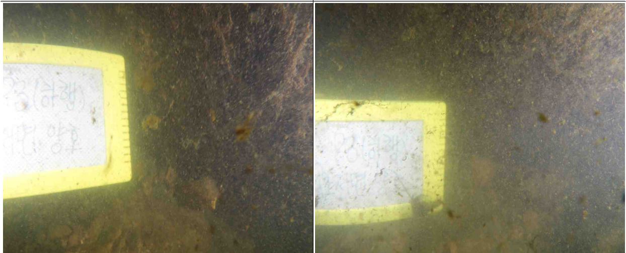
P3하행 교각 기초저면, 상태 양호
