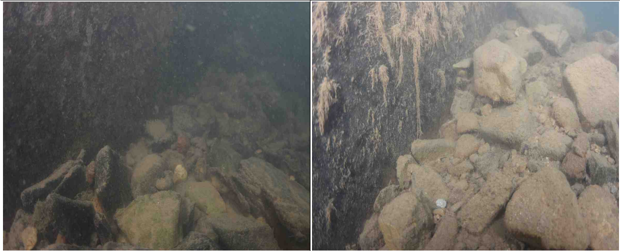
P4하행 교각 기초저면, 상태 양호
