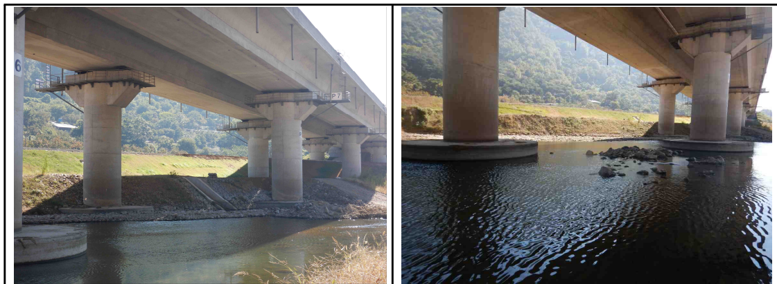
청도천4교 전경 및 조사대상 교각
